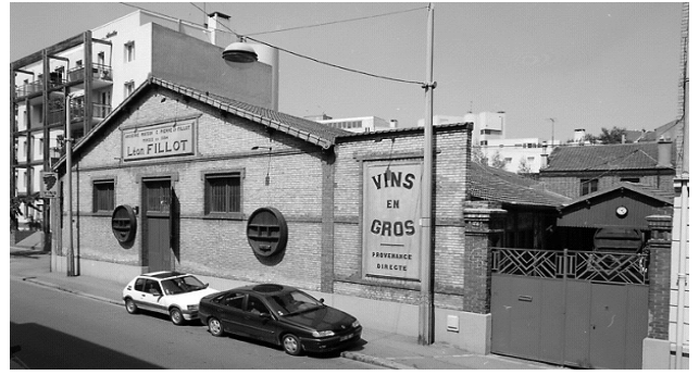
Entrepôt vinicole, usine d'embouteillage dite usine Fillot. Photo Christian Décamps, 1997. Service Régional de l'Inventaire d'IDF. © Inventaire général, ADAGP, 1997.
